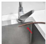
✓ 牛奶清洗废水管安装完成。
